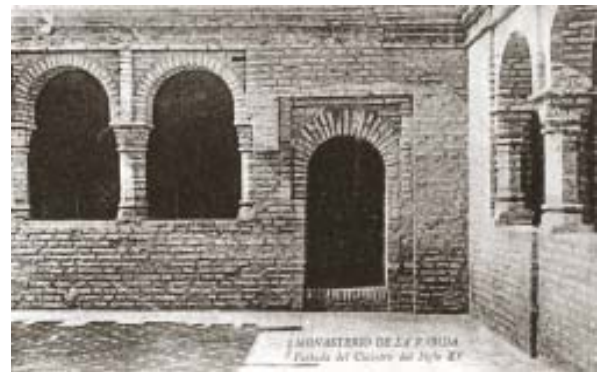
La fachada del Claustro.
