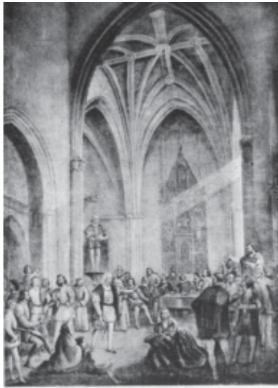
Puerto - Palos - Cuadro existente en el Monasterio de la Ribáda, - Lectura de la Real pragmática.
